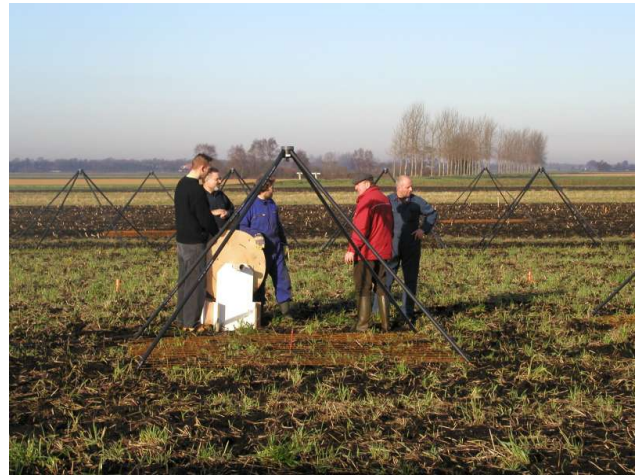
Installationsarbeiten auf der ITS
